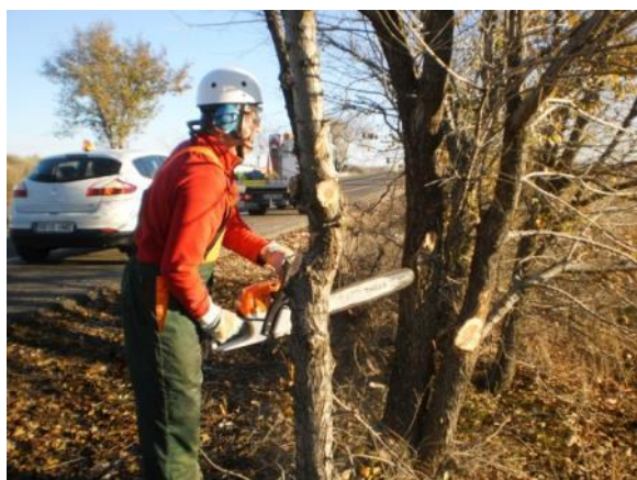
Figura 3. Poda de árbol h < 2 m con motosierra
